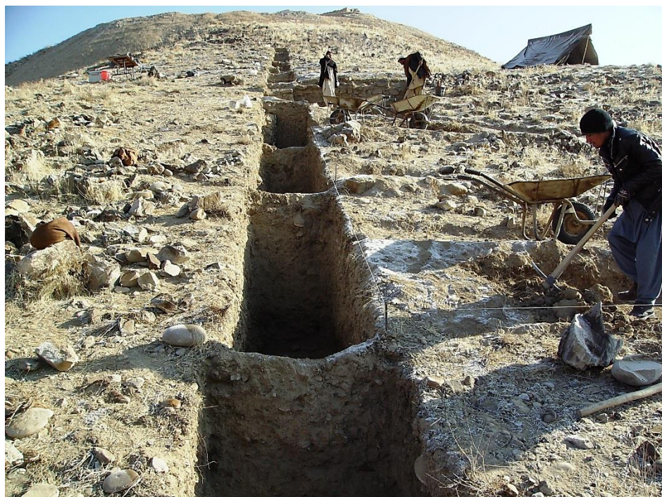
تصویر ۲: نمای ترنج امتحانی در سمت غربی شاه تپه بمنظور تثبیت ساختمانها، عکاسی خیر زاده، ۲۰۱۴.
