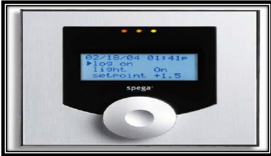
شکل 1: پنل کنترولی سیستم روشنایی و صوتی،
