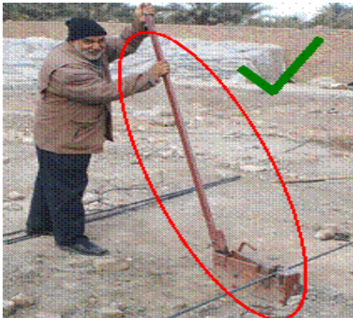
شکل 1: برش توسط قیچی میخانیکی (6: ص. 4)
