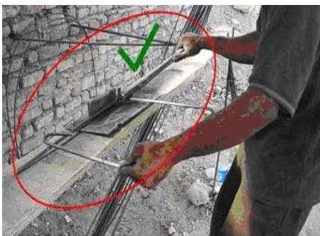
شکل 2: خم کردن سیخ گول روی میز (6: ص. 2).
