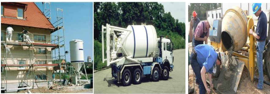
شکل 4: سیستم اختلاط ماشینی مصالح
