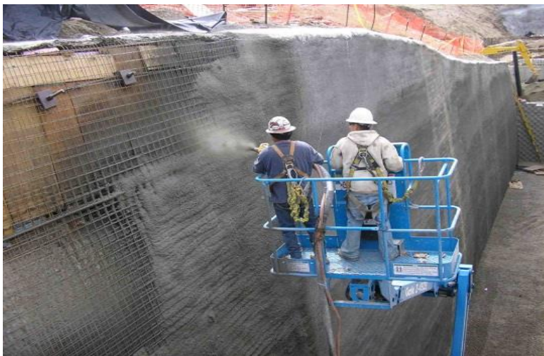
شکل 5: سیستم اختلاط ماشینی و پمپاژ مصالح
