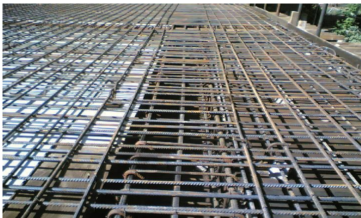
شکل 1: کاربرد سیخ گول ( فولادی ) در سیخ بندی ساختمان
