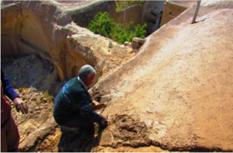
شکل 1: عایق کاری از مصالح کاه و گل
