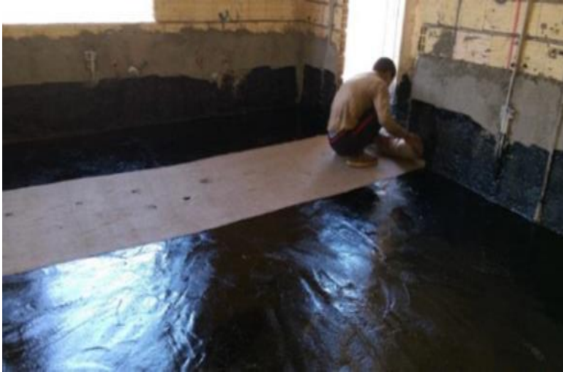
شکل 1: عایق کاری رطوبتی قیر و تات
