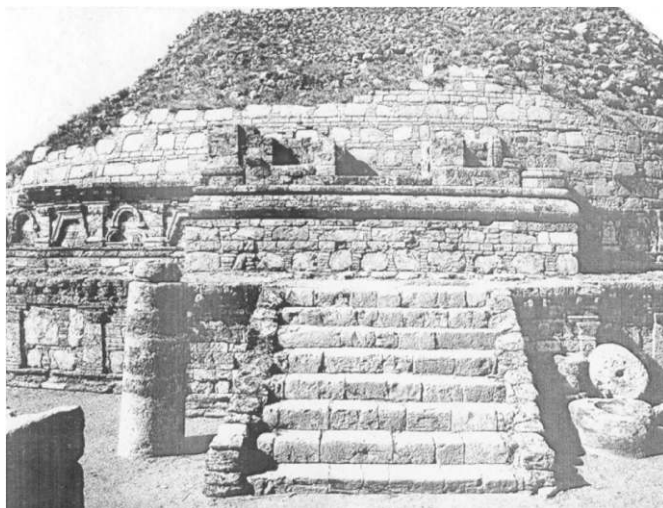
(تصویر ۱۵) سمت شرقی دیتایل ستوپه دهرماراجیکا.
