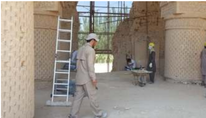
تصویر شماره (۳) نمای مسجد نه گنبد قبل از حفاری و خاکبرداری، عکاسی: فرهاد هجران، ۱۳۹۸.
