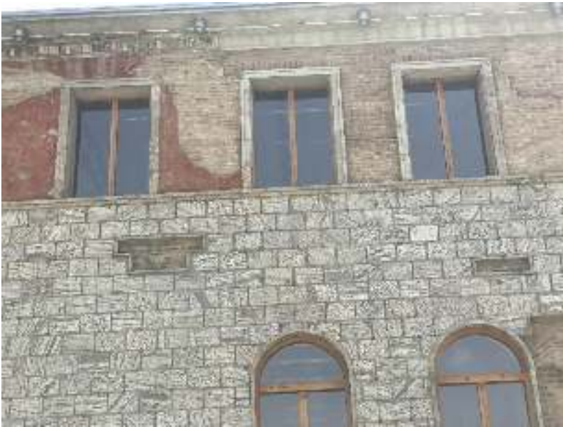
تصویر شماره ۸: نمای از مرمت قصر تاریخی چهلستون با تفکیک کارهای جدید از قدیم آن: شهر کابل، (۲۰۱۹)
