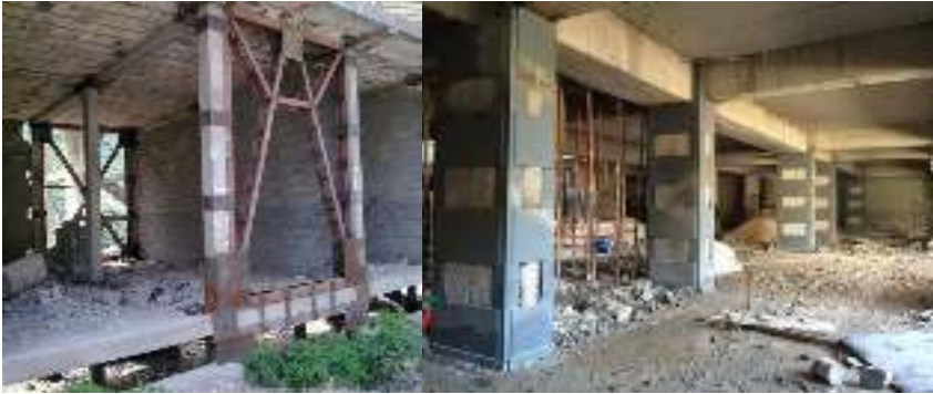
شکل 2: تقویه پایه های ضعیف توسط تسمه های فلزی (کار ساحوی).
