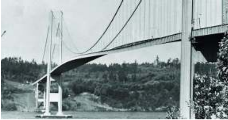
شکل 6. حالت پیچشی لحظه قبل از فرو ریختن پل Tacoma Narrow (4)
