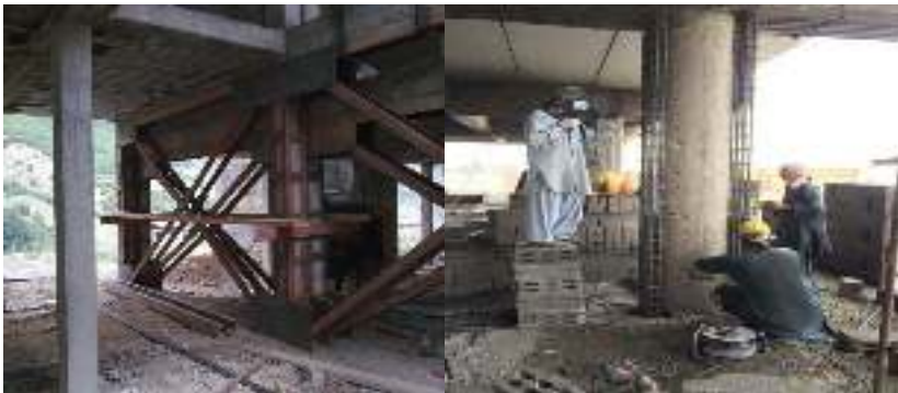
شکل 3: تقویت پایه ها و گادر ها توسط پوشش های فولادی (کار ساحوی).
