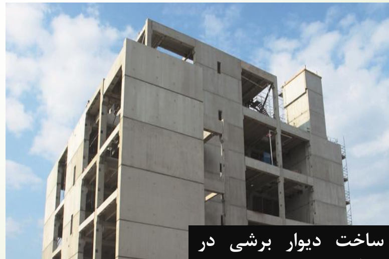
ساخت دیوار برشی پیش ساخته
