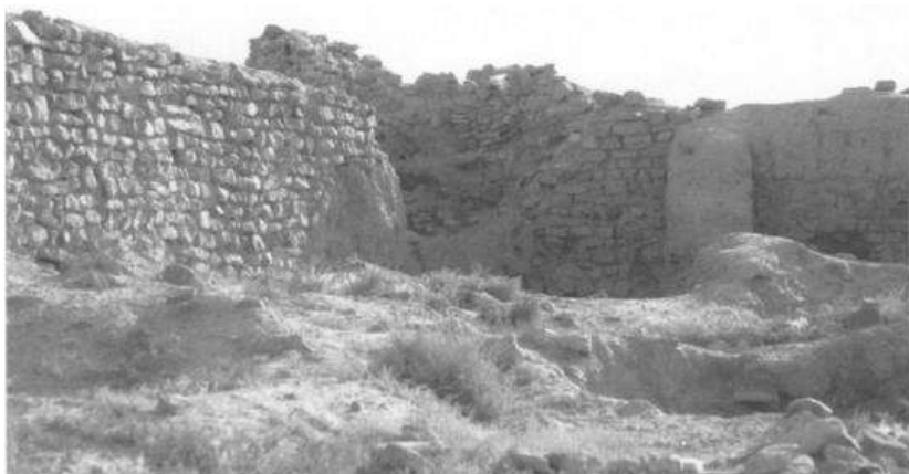
شکل ۳۹. قلعه یی حنیفه، سیغان: داخل قلعه که جزئیات نمای بیرونی سنگ خشک را نشان می دهد دیوارها و داخل سنگر جنوب غربی.
