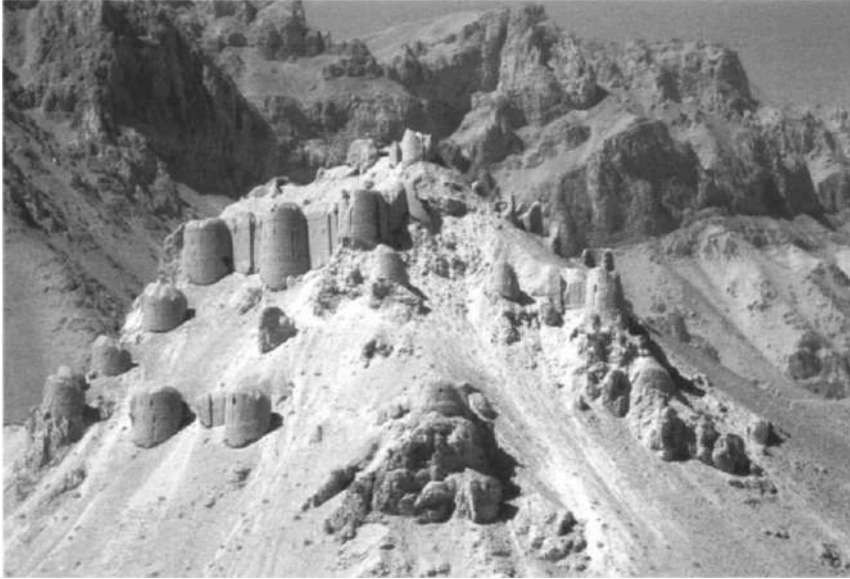
شکل ۱۵. دیوارهای جنوبی و شرقی چهل برج که از جاده اصلی دیده می شود.
