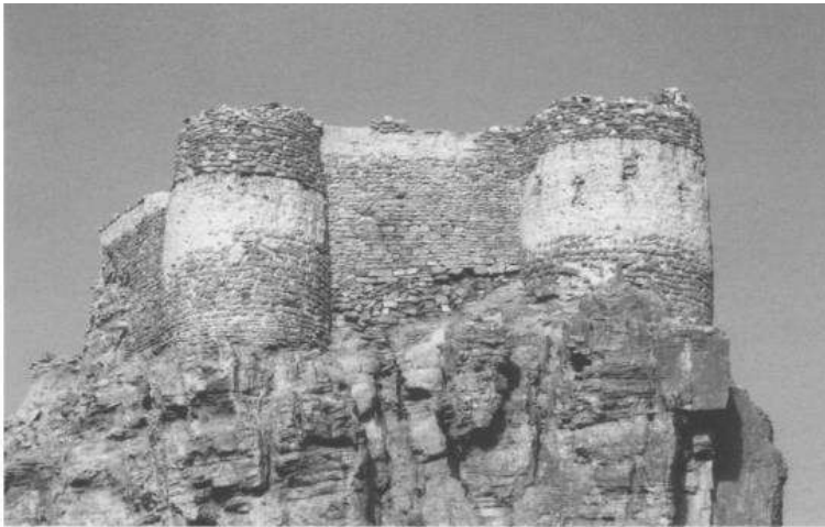
شکل ۳۸. قلعه بی حنیفه، سیغان: دیوار غربی و برج های دیواری
