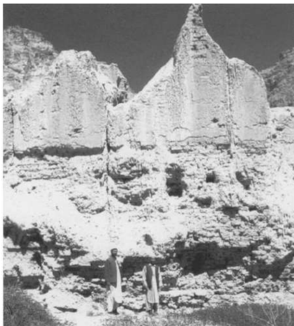
شکل ۲۷. کلیگان: دیوار جنوبی ساختمان اصلی.
