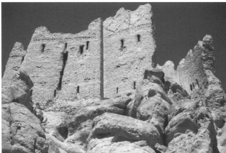
شکل ۳. قلعه بی گوهرگین، ضلع جنوب شرقی: نمای از دره که جزئیات موقعیت اصلی دیوار در برج را نشان می دهد
