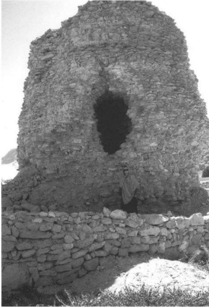
شکل ۲۹. کلیگان ضلع شمال غربی برج
