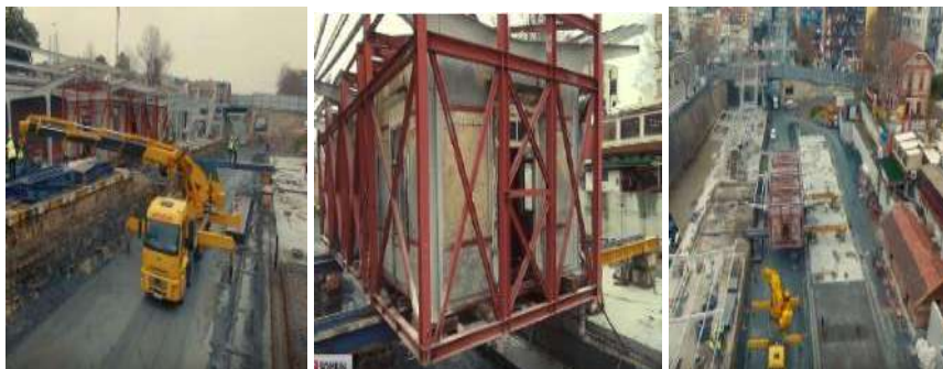
(تصاویر ۴۲، ۴۳ و ۴۴) فرآیند حمل و نقل ساختمان (URL 9).
