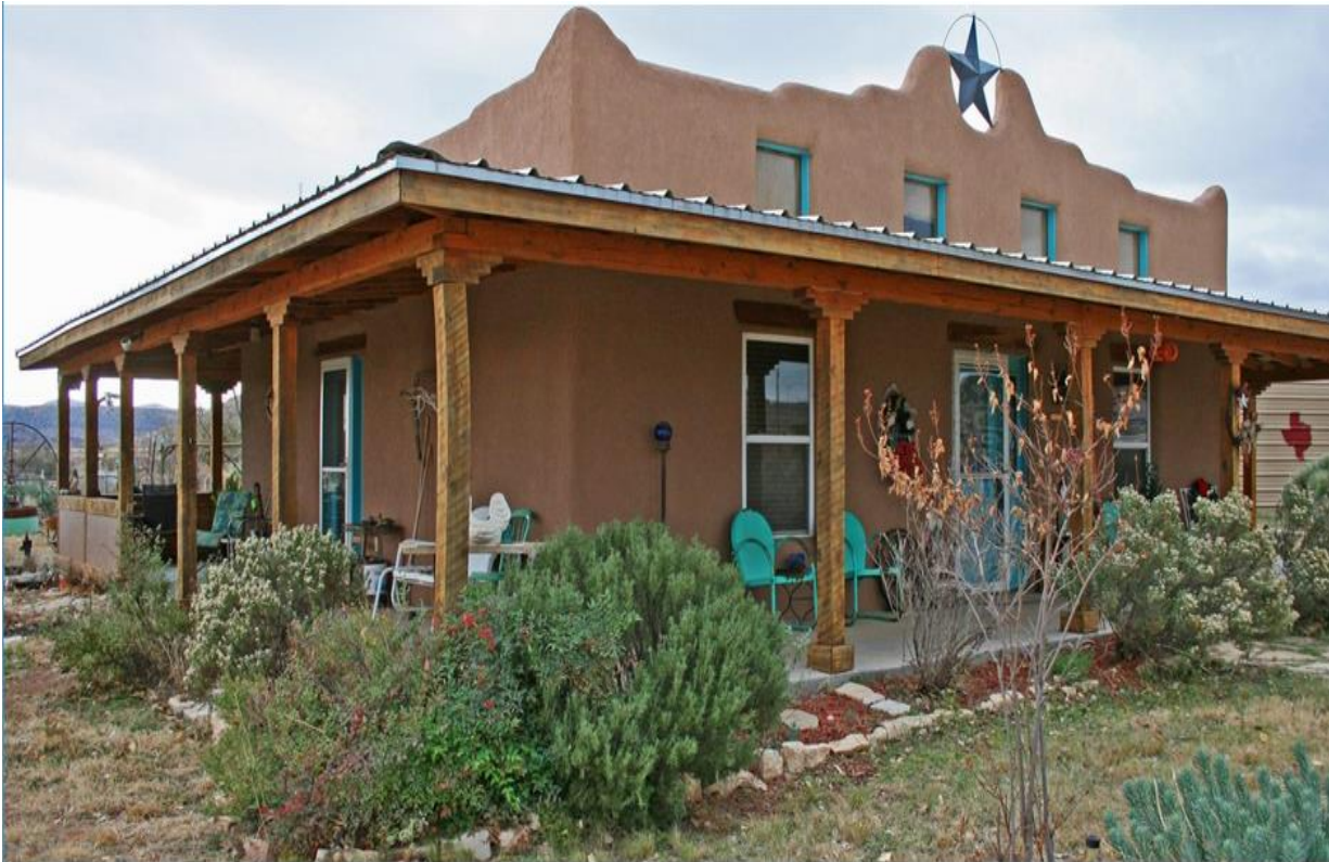
شکل (11): ساختمان ساخته شده توسط پیپرکریت (Curry, n.d.)
