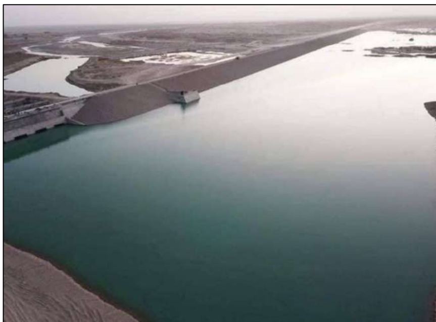
شکل 3. نمای بند ذخیروی آب کمال خان.
