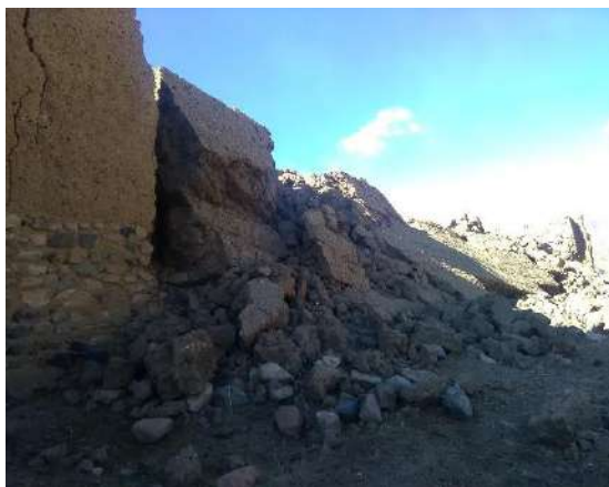
تصاویر ۱ و ۲: نمای تخریب دیوار سمت شمال شرق قلعه قدیمی سرکالو (کاروان سرای)، عکاس: عبدالمجید جلیا، ۱۳۹۶.
