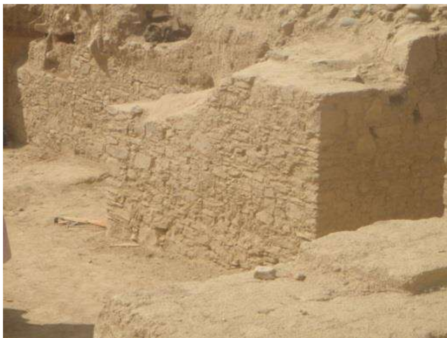
تصویر ۸. قسمتی از دیوار جنوبی معبد گلحمید که دو دوره ساختمانی را نشان میدهد، عکاسی: سرمحقق کتاب خان فیضی، ۱۳۸۸.
