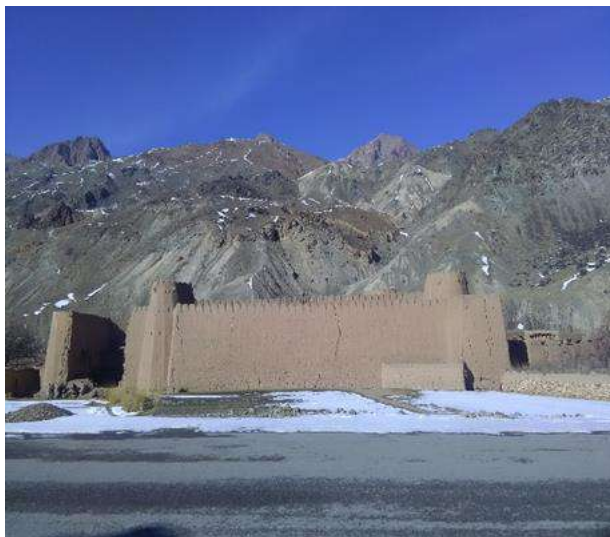
تصویر ۱۷: نمای عمومی سمت جنوبی و دروازه قلعه تاریخی لخشوم قلعه قریه بلوله در جریان سروی، عکاس: عبدالحمید جلیا، ۱۳۹۶.
