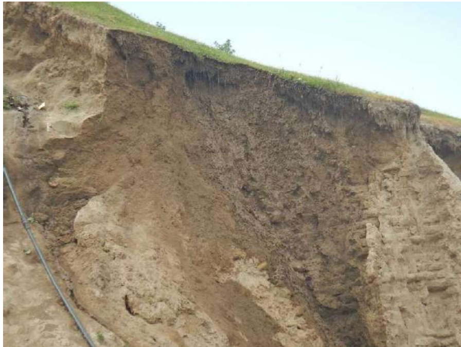
تصویر ۱۶. تخریبات ساحه ناشی از گذاشتن ذخیره آب در بالای ساحه؛ عکاس: سلطان مسعود مرادی، ۱۴۰۳.
